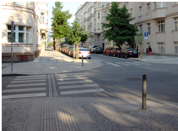
Křižovatka zklidněných ulic s rozšířením chodníku sníženým do úrovně vozovky a přechody na všech ramenech křižovatky [ Praha 6, Eliášova | foto: Tomáš Cach ]
