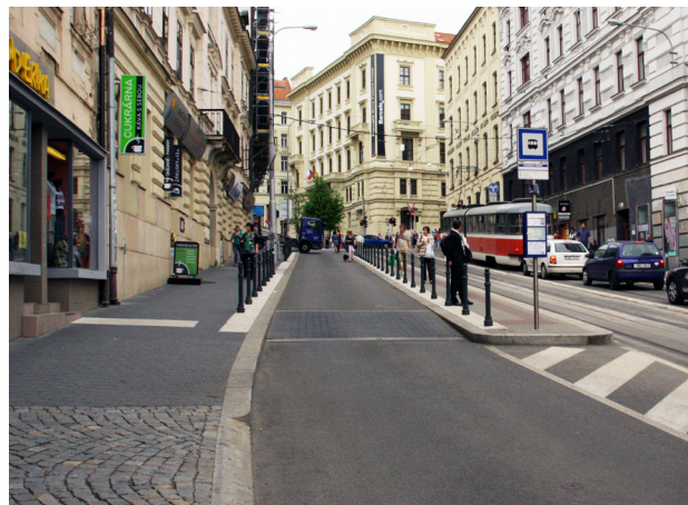
Vhodně zvýšená vozovka podél úzkého tramvajového ostrůvku včetně bezbariérové úpravy pro nevidomé [ Brno, Šilingrovo náměstí | foto: Vojtěch Novatný ]
