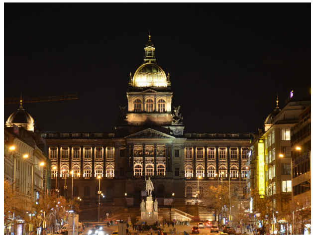
Vhodná kombinace plošného architekturního osvětlení a světelného zdůraznění vybraných částí budovy [ Praha 1, Václavské náměstí | foto: Petr Žák ]
