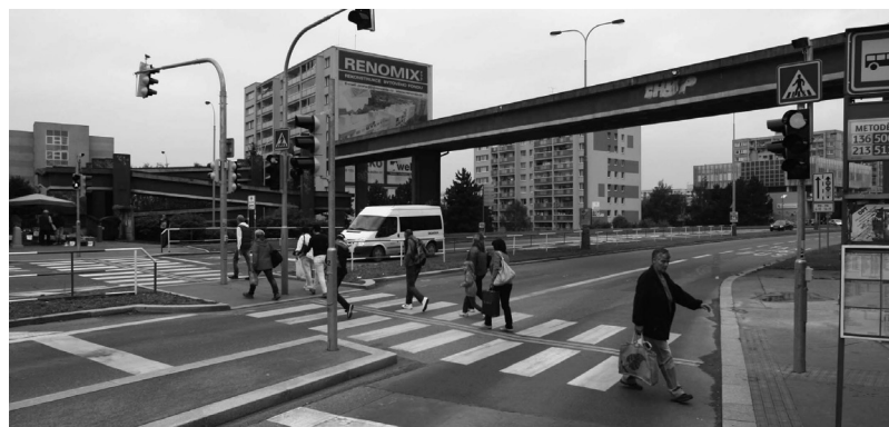
[ OBR. 19 ] Nevhodně řešené mimoúrovňové křížení pěšího pohybu s komunikací. Pro nefunkčnost byl nakonec paralelně zřízen úrovnňový přechod. Jižní Město, Praha
