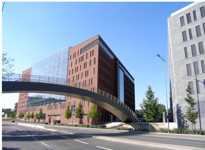
Foto I přes vysokou architektonickou úroveň je novostavba Danube House v Karlíně z hlediska kulturních hodnot nepříznivá, neboť objekt postrádá parter otevřený městu a nenabízí přátelské městské prostředí
