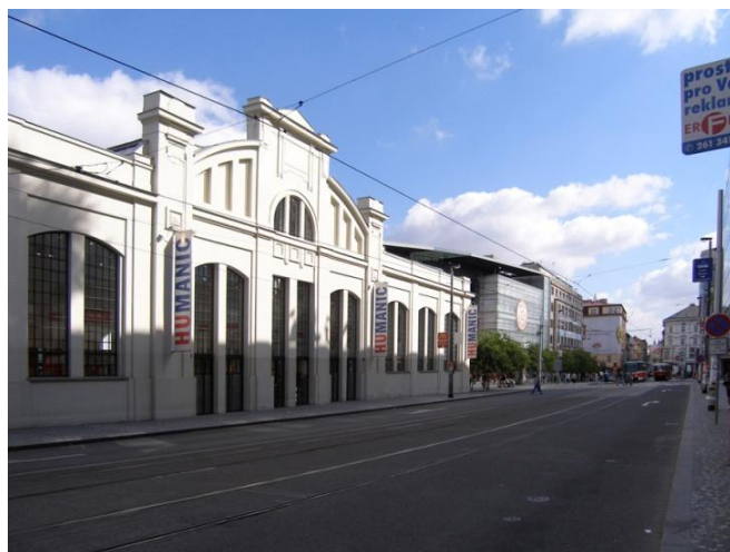
Foto Příklad „fasádismu“ – průčelí továrny Tatra Smíchov sice zůstalo zachováno, bohužel ale nebyla využita možnost zachování tohoto průmyslového dědictví v podobě alespoň částečné rekonstrukce závodu
