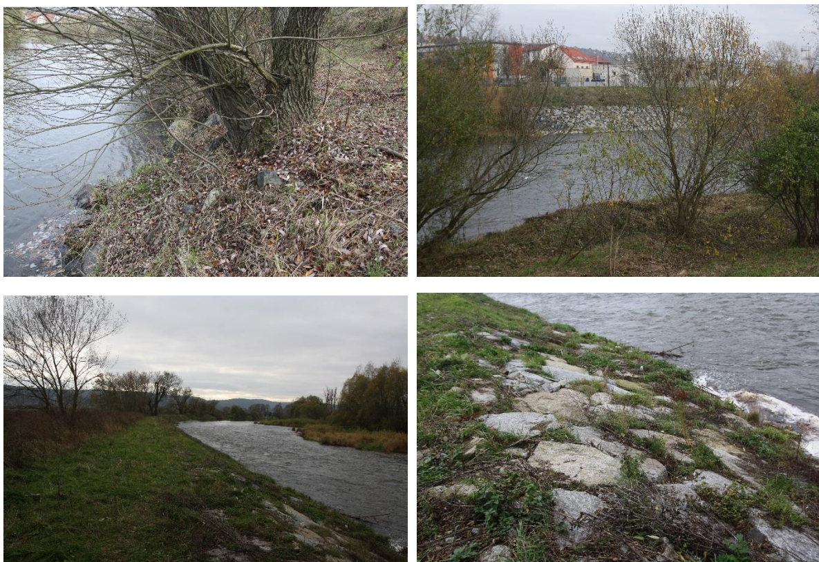
Obr. 9: Opevnění koryta Berounky v území Příměstského parku. Vlevo nahoře – renaturace kamenného záhozu na pravém břehu v severní části Radotína. Kamenná rovnanina na levém
