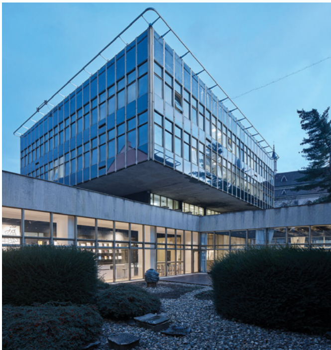
Pohled z atria na pavilon A. Zdroj: IPR Praha, foto: BoysPlayNice
